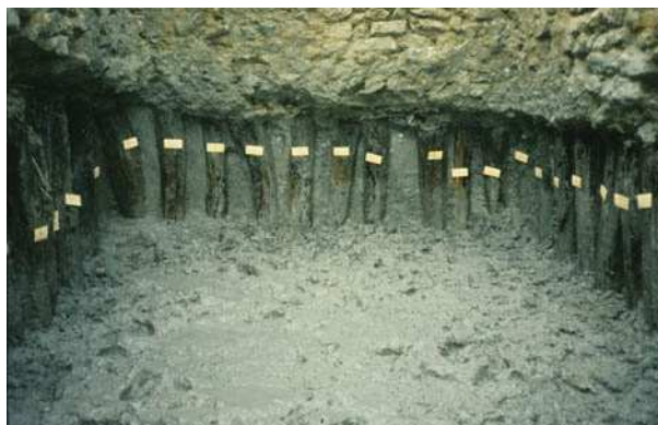
Pilots de bois utilisés à la fondation du cirque
