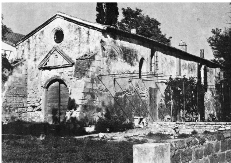
Église de Villeneuve avant travaux (cl. Michèle Brabo)
