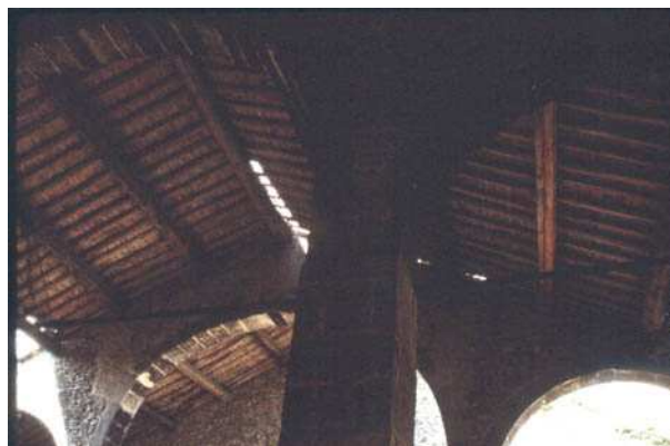
Corps de bâtiment E, étage, vue de volume des arcs portant la couverture
