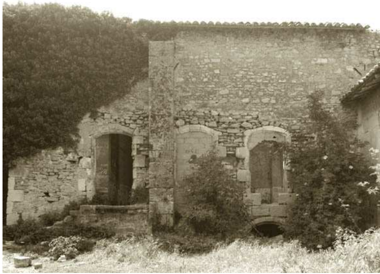
Corps de bâtiment E, façade est, vue de la partie dégagée
