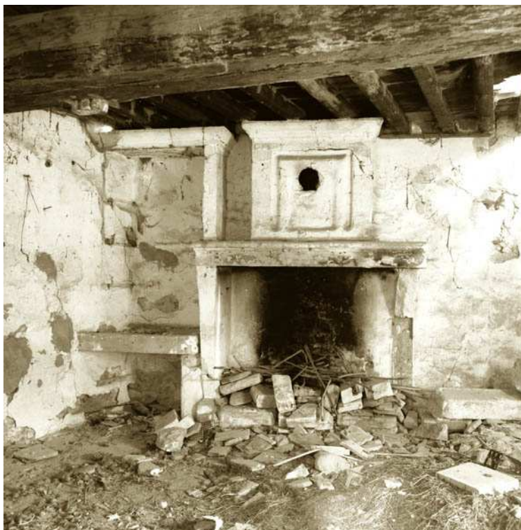
Corps de bâtiment F, logis Fc, rez-de-chaussée, évier et cheminée
