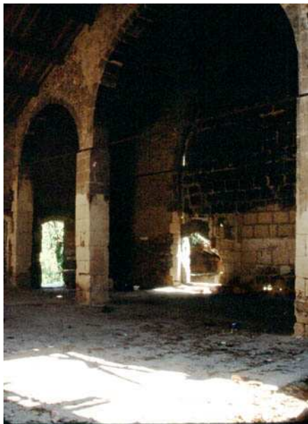
Corps de bâtiment E, étage, vue de volume des arcs portant la couverture
