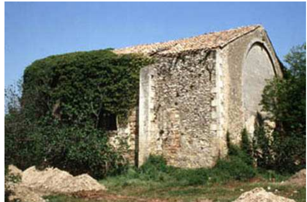
Corps de bâtiment E, vue prise du sud-ouest
